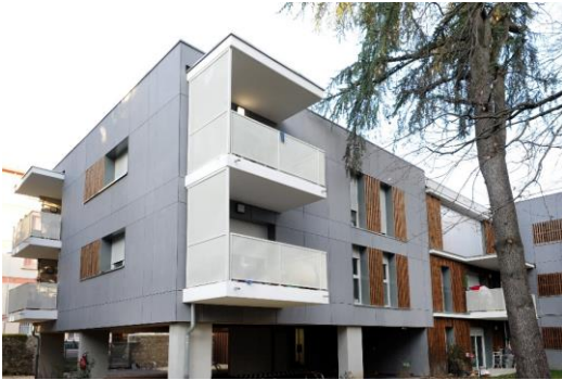
Grenoble Rue Roger Guigue Construction neuve 12 logements
