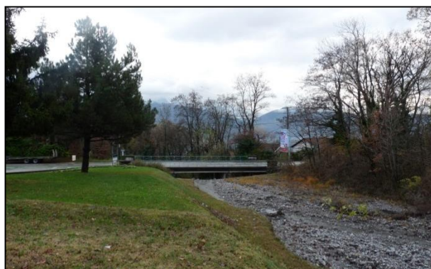
Pont de la RN 90
