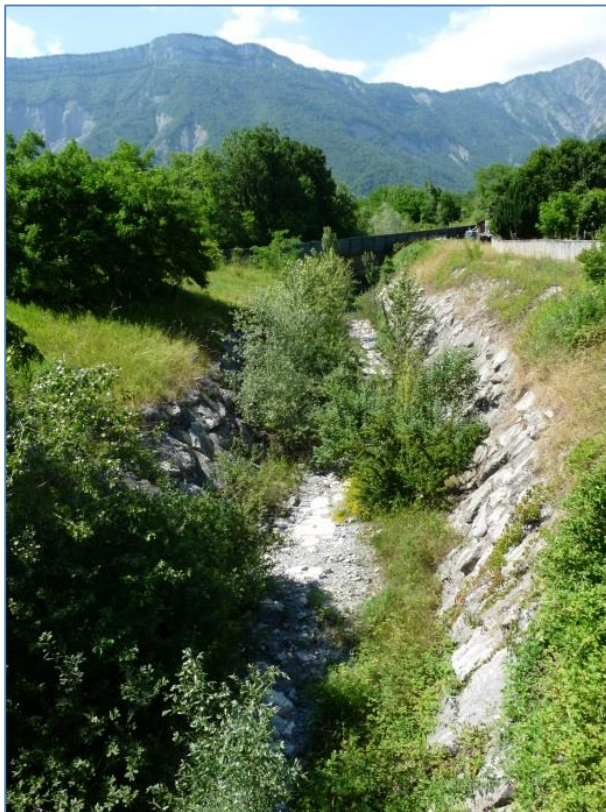
Torrent du Manival aval Chemin de la Touvière
