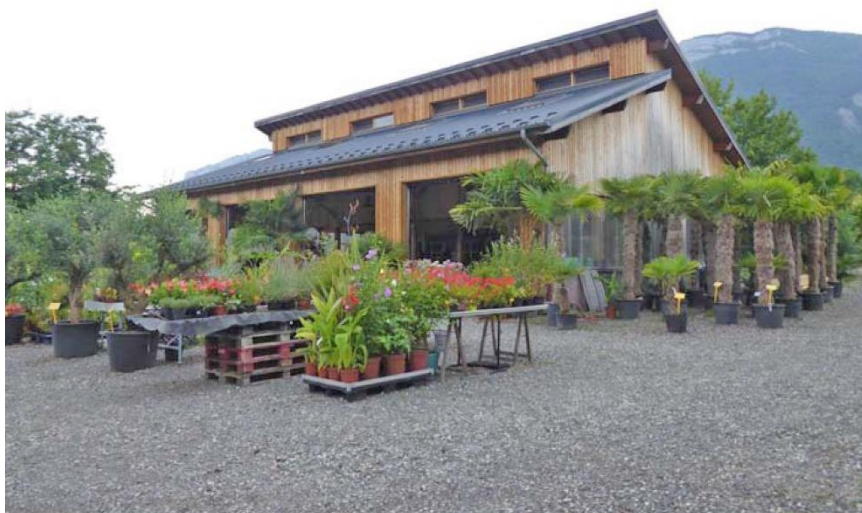
Hangar existant destiné à être réaménagé en restaurant éco-diététique
